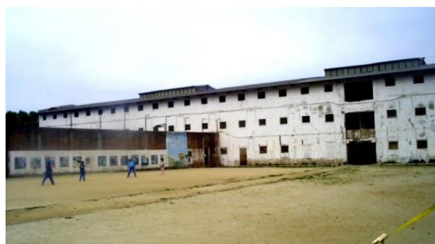
Fig. 6 Galería de reos, destruida. Fotografía: Parque Cultural de Valparaíso.
